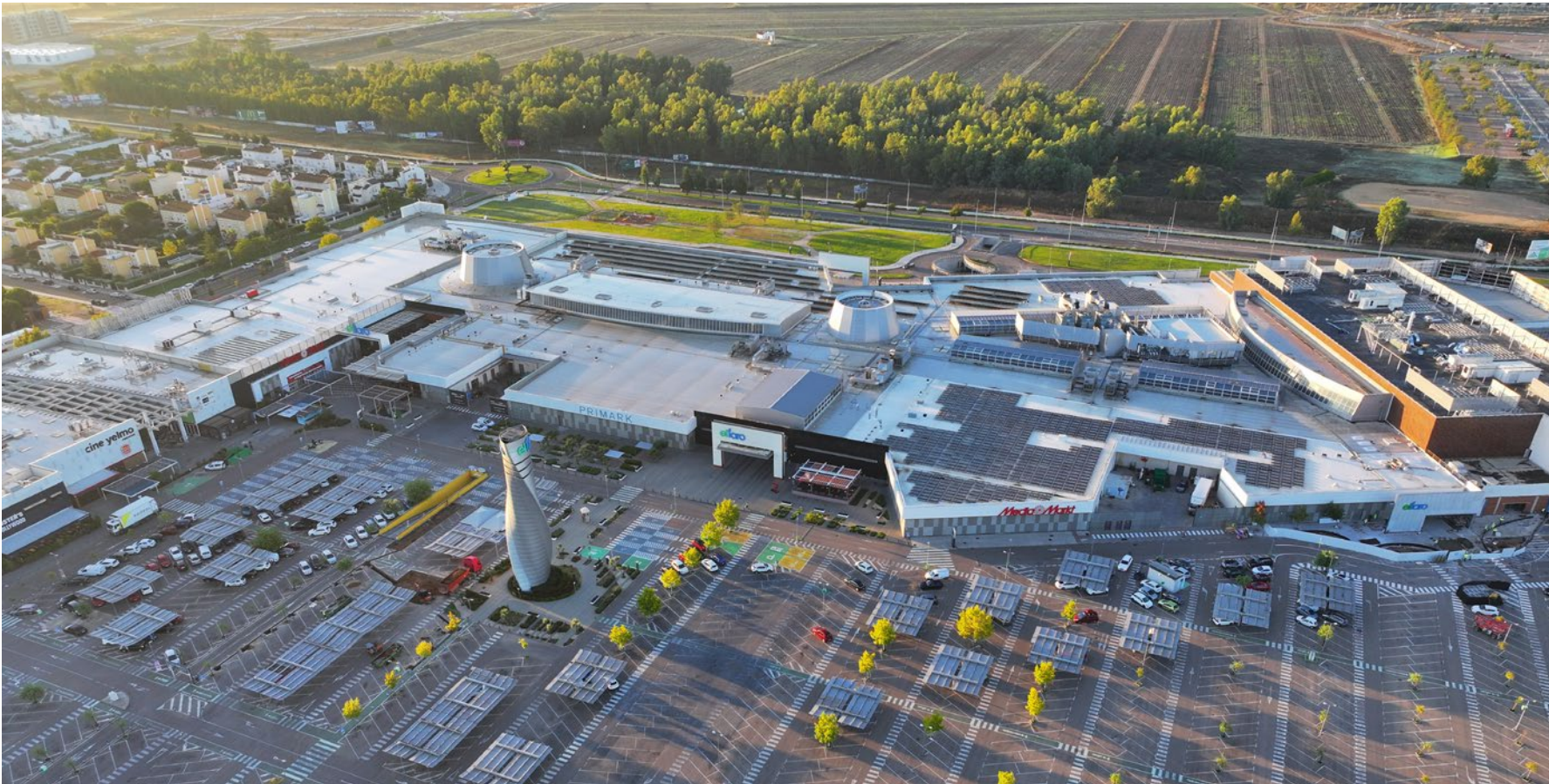
BELOW: Centro Comercial El Faro
